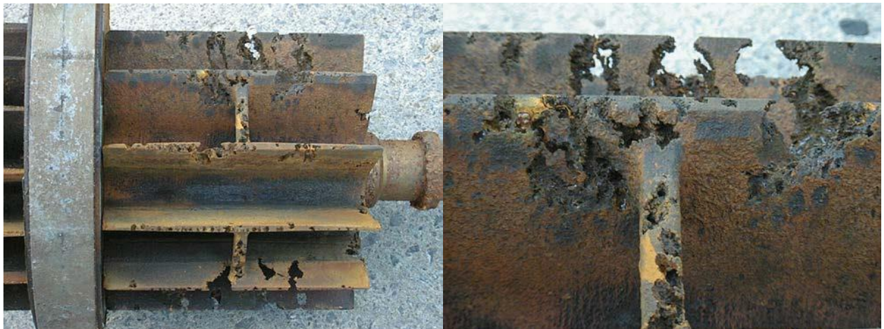
Kavitations skader på vakuumhjul
