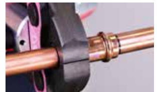
12. Tryck på beslaget med det godkända pressverktyget
