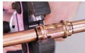
11. Styr monteringen i pressklon
